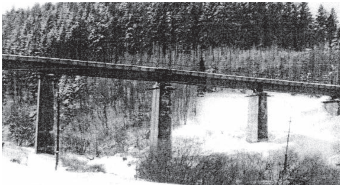
WIADUKT KOLEJOWY NAD DOLINĄ W MIEJSCOWOŚCI ROZŁUCZ
