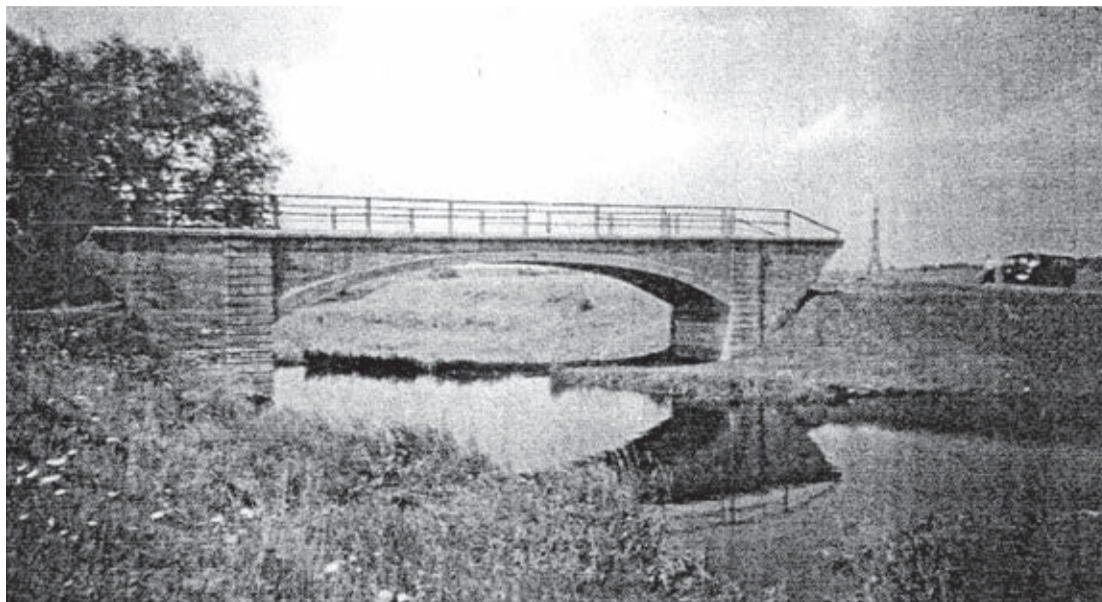
MOST NA KANALE MELIORACYJNYM ZBUDOWANY W 1914 R.
