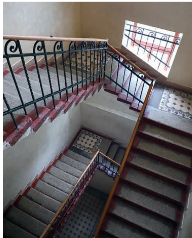
KLATKA SCHODOWA W DAWNYM GIMNAZJUM
