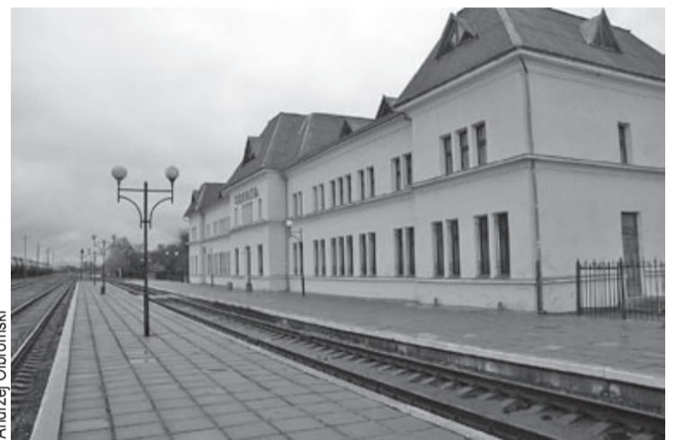
Dworzec kolejowy w Sokalu
