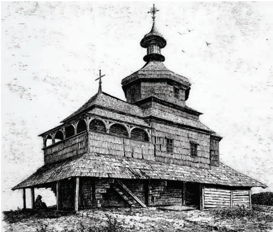
Cerkiew Wniebowzięcia NMP okradziona w 1754 roku
