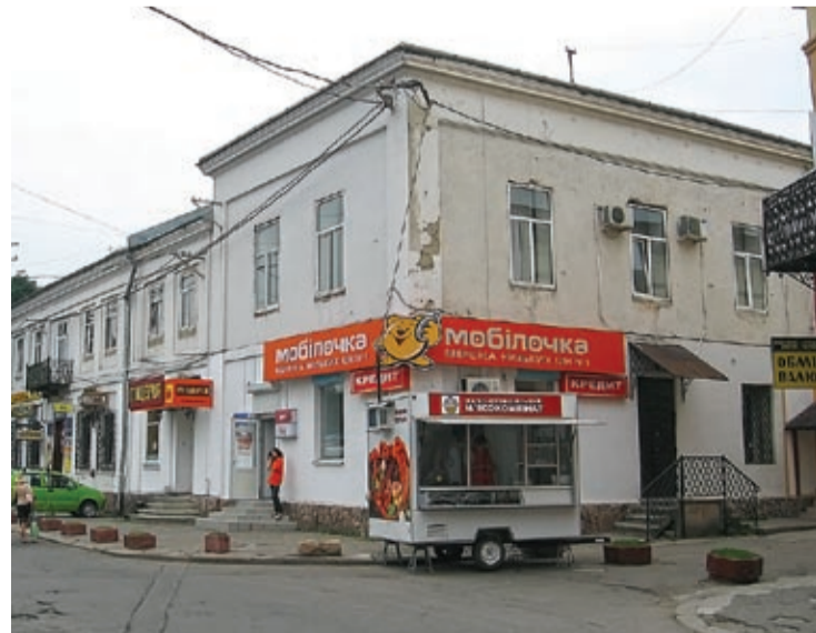
Dzisiaj ta budowla mało przypomina klasztor trynitarzy
