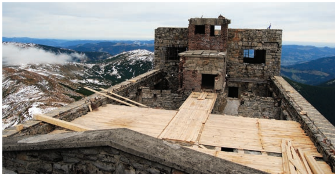
Do zimy będzie dach
