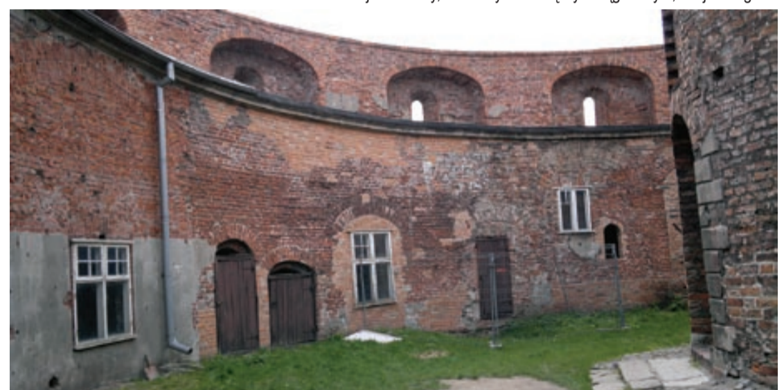
Wewnątrz twierdzy. Po lewej u góry, stanowiska artyleryjskie na wieńcu. Po prawej mur wieży
