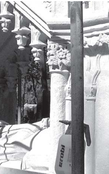
Prace przy pomniku na grobie abp. Stefanowicza
